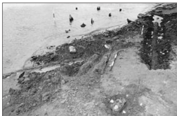
20. kép: A cölöphíd in situ feltárt szerkezeti elemei (fotó: Ratkai Barnabás).
